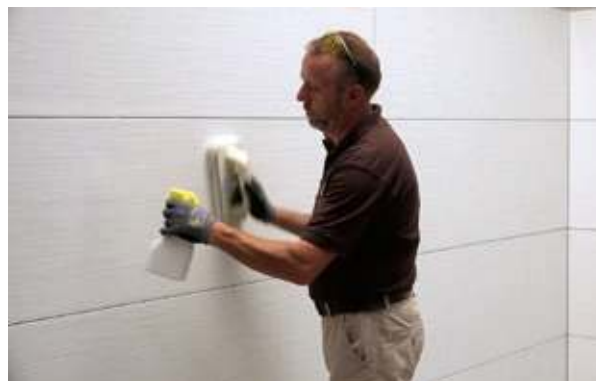
15. Al fine di eliminare tutti i residui di posa ed il normale sporco di cantiere, si procede alla pulizia della parete con dei prodotti professionali specifici. 15. In order to remove all laying residues and any dirt from the construction site, the wall is cleaned with suitable professional products. 15. Nettoyer le mur avec des produits professionnels spécifiques afin d'éliminer tous les résidus de pose ainsi que la saleté normalement laissée par le chantier. 15. Um alle Verlegerückstände und normalen Baustellenschmutz zu beseitigen, wird die Oberfläche mit speziellen Fachprodukten gereinigt. 15. В целях устранения всех остатков материалов для укладки, приступаем к уборке стены, используя специальные средства.
