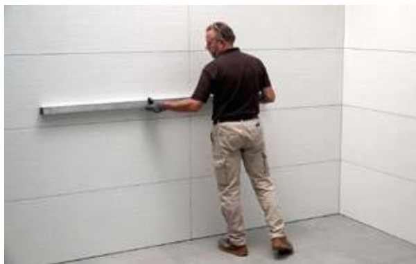
14. La parete si presenta perfettamente planare. 14. The wall is perfectly level. 14. Le mur est parfaitement plat. 14. Die Wand ist vollkommen eben. 14. Стена идеально ровная.
