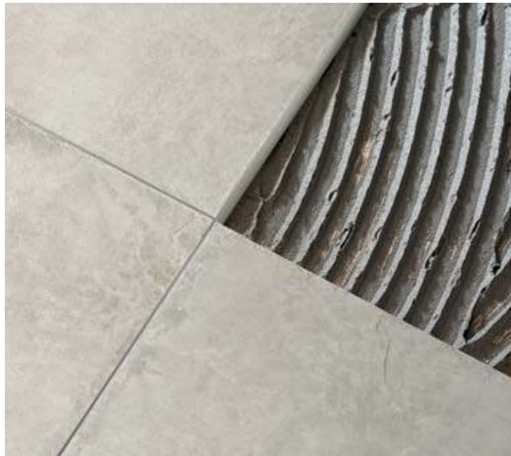
Laying on screed with adhesive. Colocación con adhesivo.
