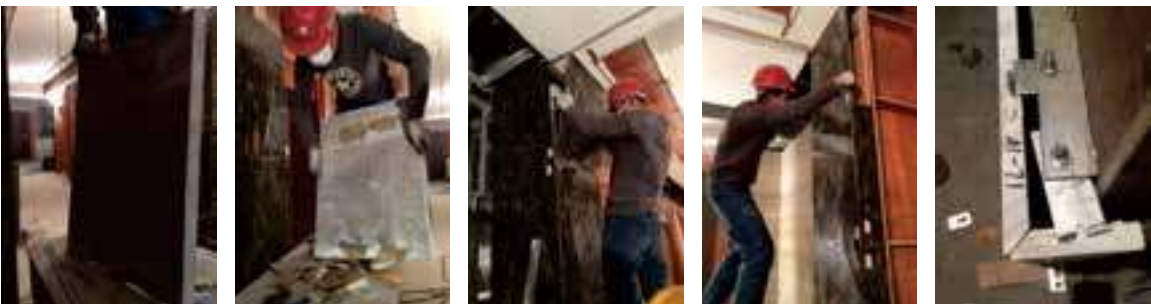
开槽 Grooving 上胶 Sizing 安装 Installation 调位 adjustment position 固定 Fixed
