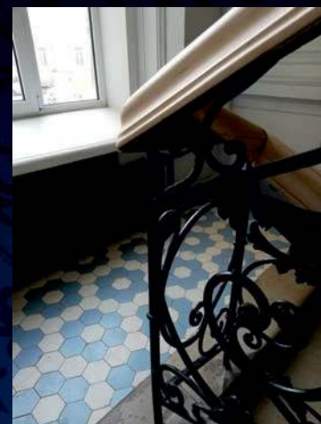
Москва, ул. Покровка. Подъезд
