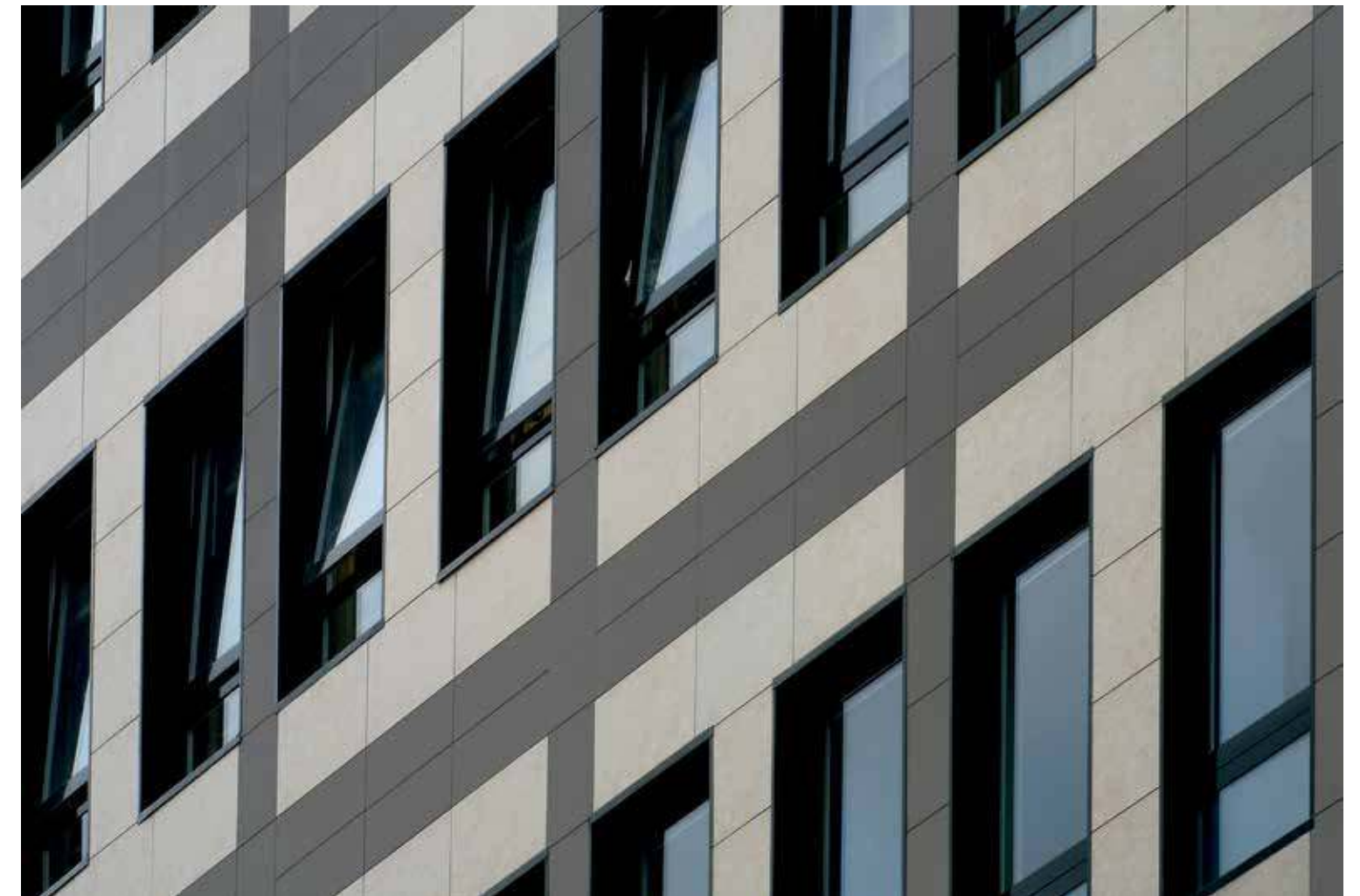
Fachada ventilada de uno de los edificios que forman parte de la Biblioteca Municipal en el municipio de Ermua. Arquitecto D. Benjamín Palacios. Ventilated façade of one of the buildings of the Municipal Library in Ermua (Spain)
