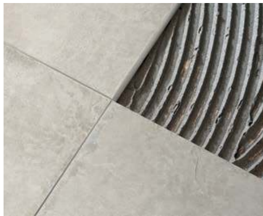
Laying on screed with adhesive. Colocación con adhesivo.
