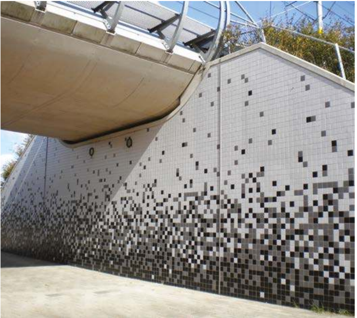
Sottopasso pedonale - Olanda
