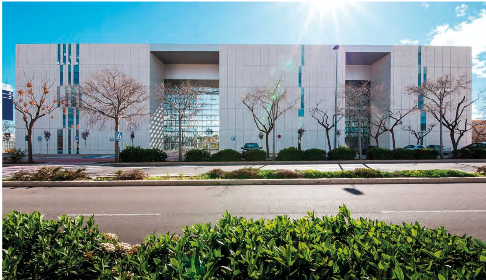
Fachada Facultad Ciencias de la Salud, Castellón 2018.
